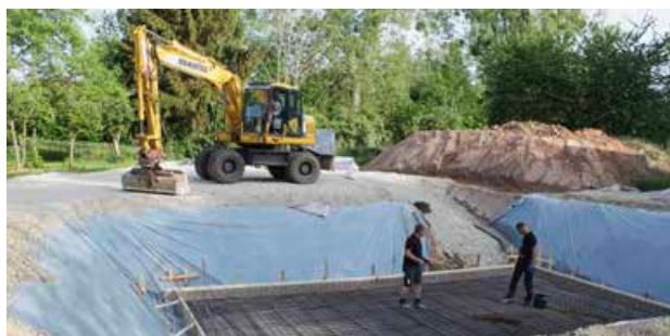
Auf der Baustelle hat sich bereits viel getan: Die Bodenplatte ist ausgehoben.
