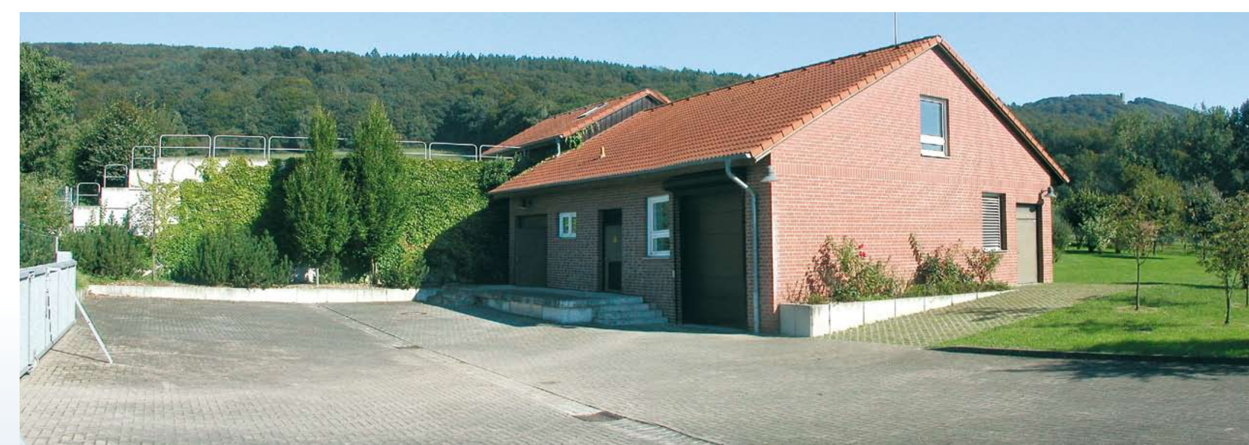
Hochbehälter Guckse – wichtiger Knotenpunkt der Rintelner Trinkwasserversorgung
